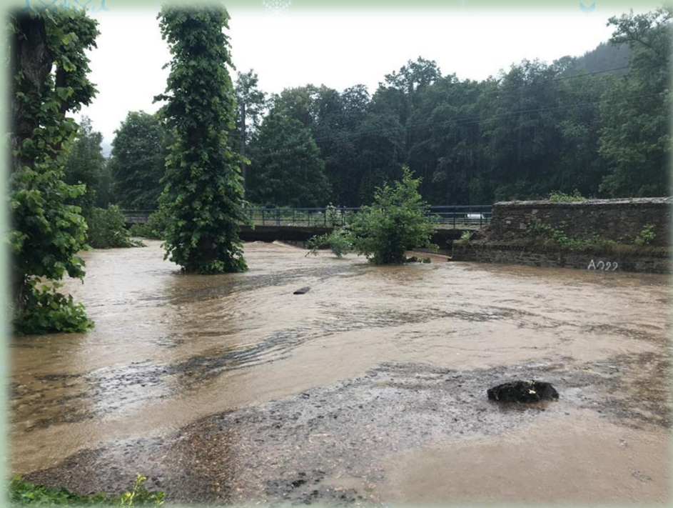
Le mur du parc a cédé face à la puissance des flots
